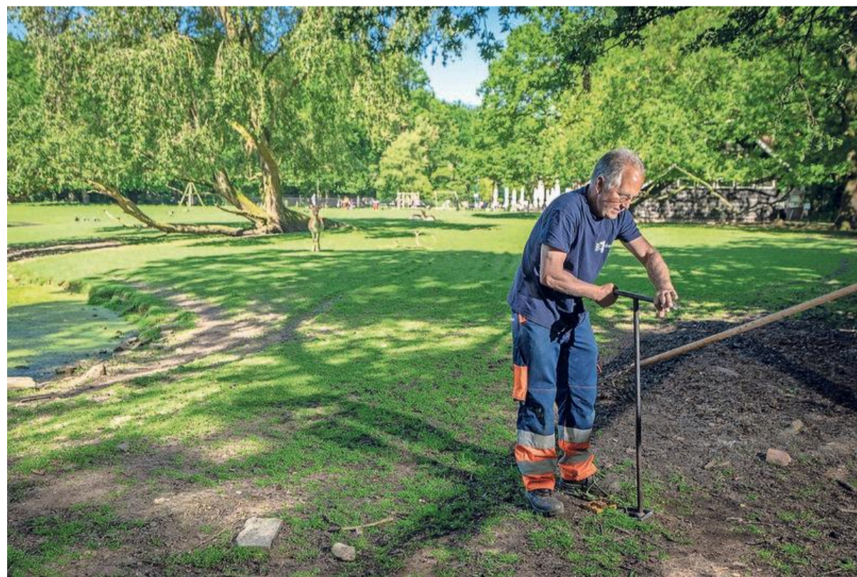
Met een spindel, een zwaar T-vormig gereedschap, draait Kieft door het hele park afsluiters open. FOTO HIELCO KUIPERS
